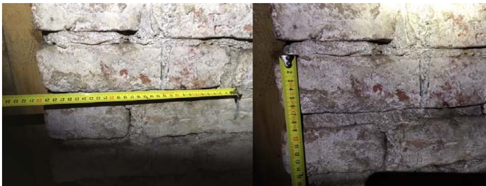
Foto 4a - Sama seina lähivaade tellise mõõtmetega.
