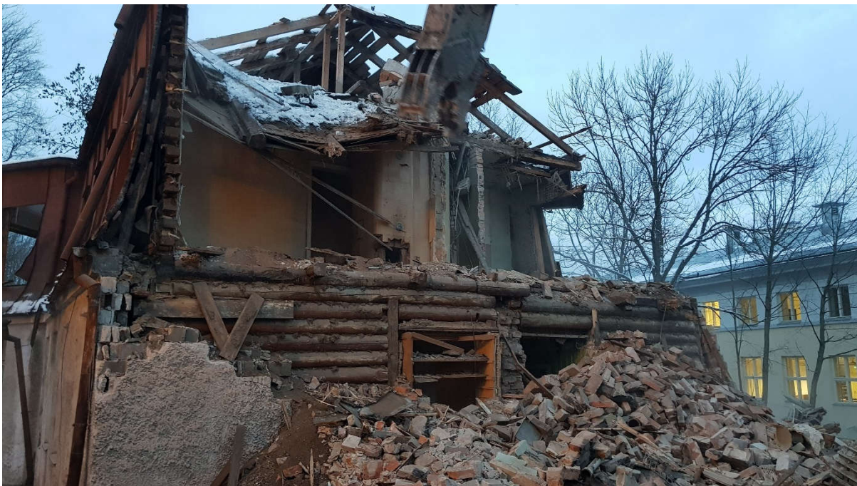
Pilt 11. Lossi tn 11 hoone lammutamine 5. detsembril 2017. Hoone konstruktsioon on nii ümarpalgist (sisemine kiht) kui ka õõneskivist. Pilt Mart Hiob 2017.
