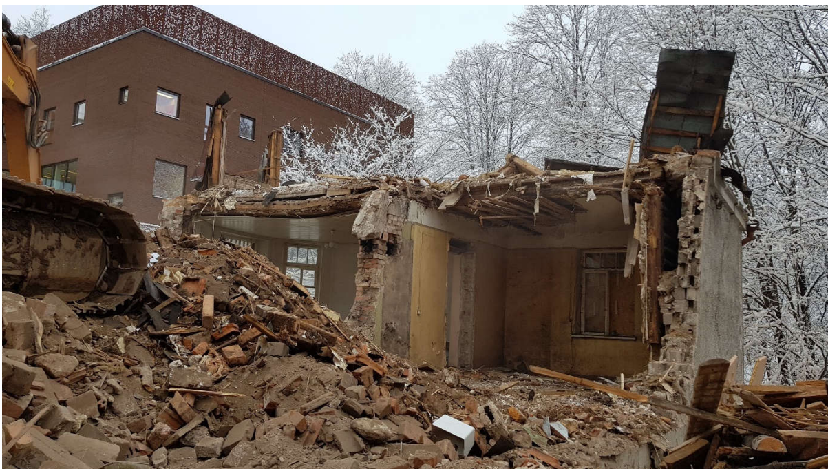
Pilt 12. Lossi tn 11 hoone lammutamine 7. detsembril 2017. Hoone konstruktsioon on nii ümarpalgist (sisemine kiht) kui ka õõneskivist. Pilt Mart Hiob 2017.
