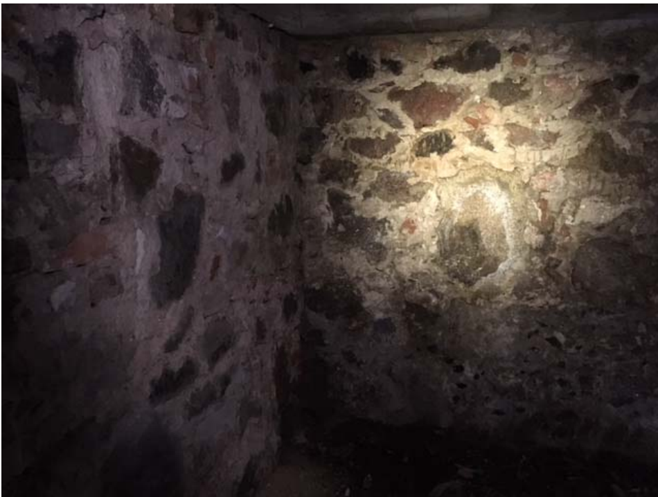
Foto 9 - Keldri põhjaseina ja kandva keskse seinä nurk.
