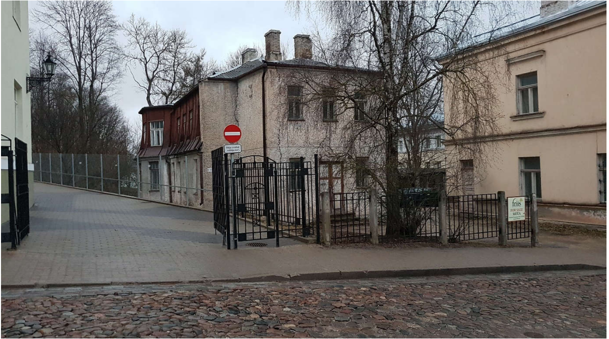
Pilt 16. Lossi tn 11 tänaseks lammutatud hoone Lossi tn 15 (vasemal) ja Lossi tn 9 hoone vahel. Pildil vasakul sissesõit H. Elleri nimelise muusikakooli peasissepääsu juurde. Pilt Mart Hiob 2017.
