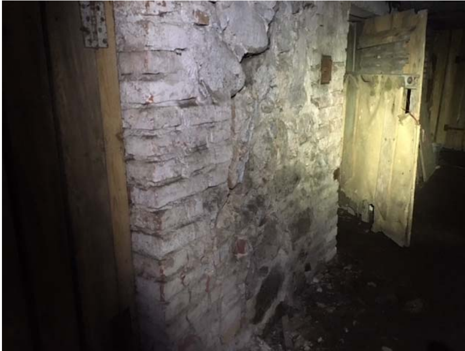
Foto 4 - Keldri keskse koridori lääneküljel paiknev kandev sein lähivaates.
