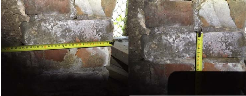
Foto 6a - Keldri idakülje müüri sees olevat aknapõske vooderdava tellise mõõtmed.
